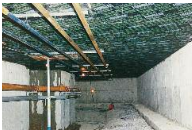
Isolation en sous-face de vide sanitaire
