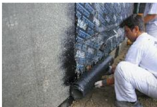
Soudage d'une membrane sur isolant FOAMGLAS®
