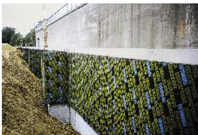
Remblayage sur isolant FOAMGLAS®
