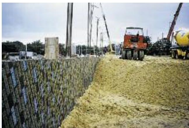
Remblayage sur isolant FOAMGLAS®
