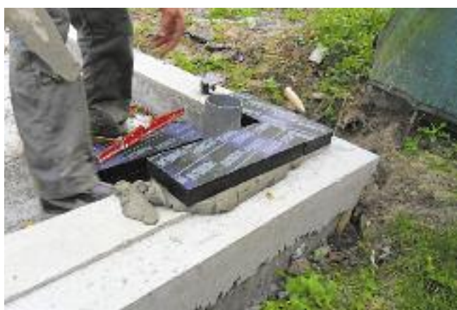
FOAMGLAS® Périnsul sous maçonnerie
