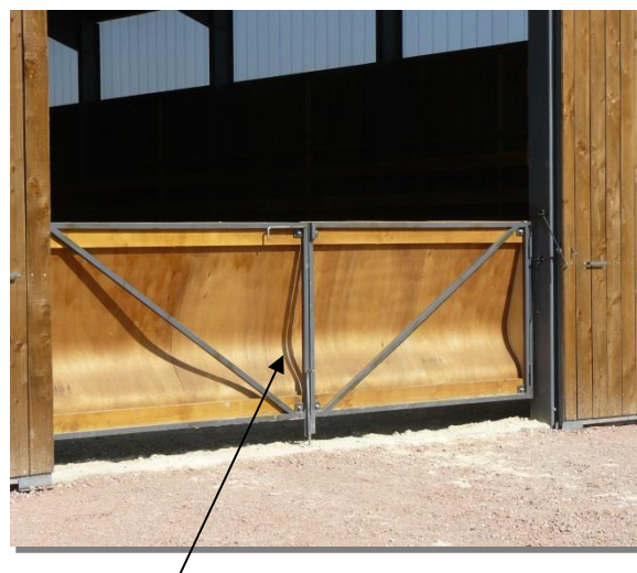
Portail : jonction des 2 portes par une coupe de biais
